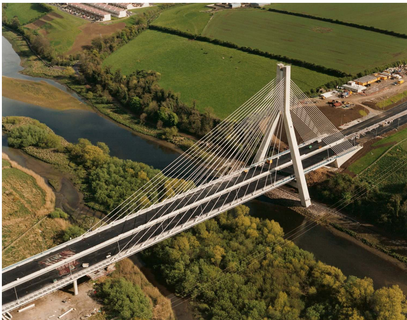
Foto aerea dell'area di studio a dx del ponte:
